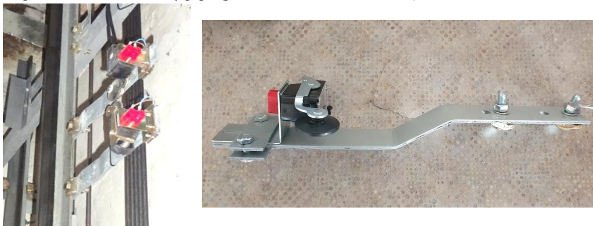
Рисунок 14.1 - Крепление концевых датчиков к направляющей лифта при помощи Z-кронштейна.
