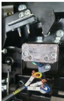
Рисунок 15.11 - Подключение датчика замка дверей кабины лифта
