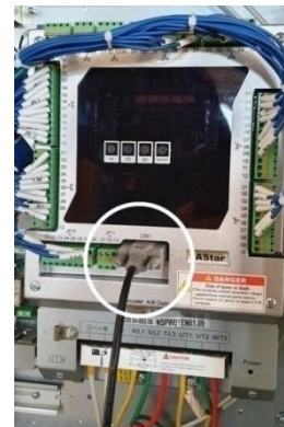
Рисунок 12.12 - Подключение пульта в шкафу управления.
