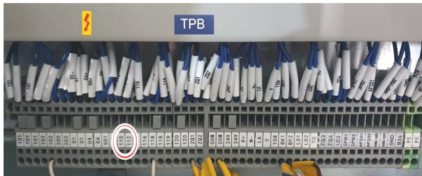
Рисунок 18.1 - Подключение концевого выключателя ограничителя скорости
