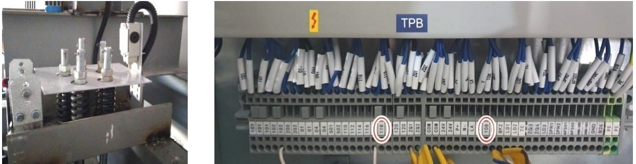
Рисунок 18.2 - Подключение концевого выключателя слабины канатов СПК
