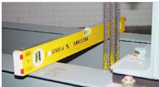
Рисунок 4.10 - Проверка уровня установки станины
