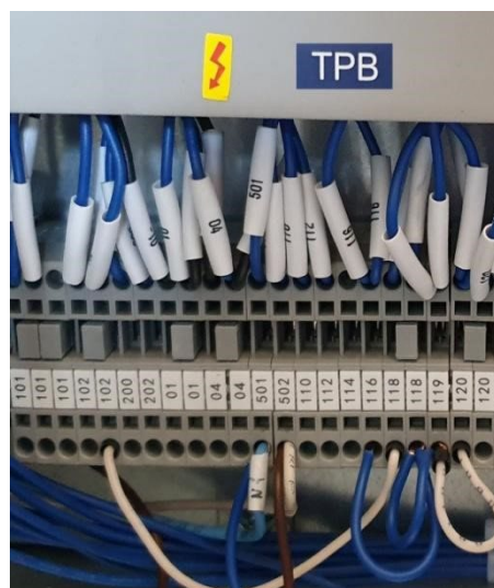
Рисунок 12.13 - Перемычки на клеммнике ТРВ
