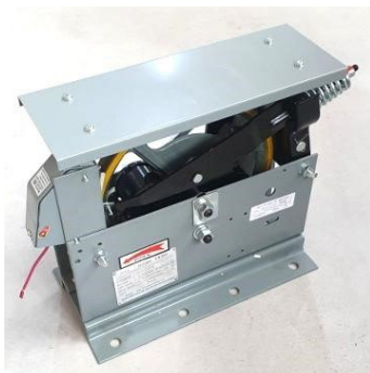
Рисунок 18.1 - Подключение концевого выключателя ограничителя скорости
