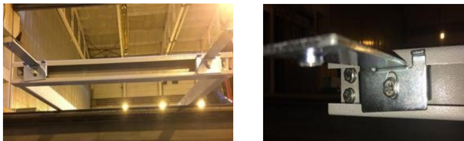
Рисунок 9.4 – Крепление спецкронштейнов этажного механизма к перемычке
