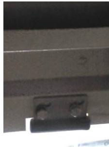
Рисунок 8.4 - Установка ползунуов двери и регулировка дверных панелей лифта
