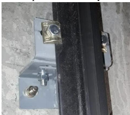
Рисунок 5.8 - Крепление кронштейна к основанию стены.
