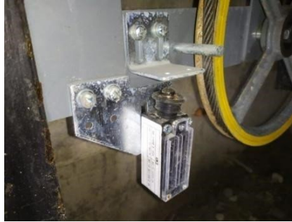
Рисунок 14.7 - Концевой выключатель натяжителя ограничителя скорости
