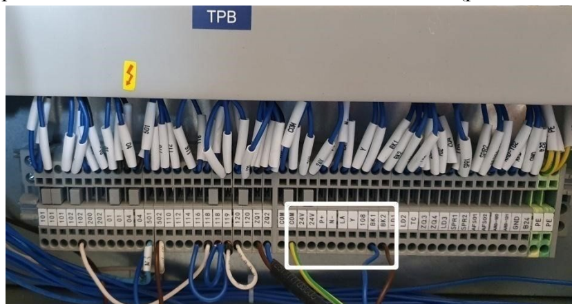
Рисунок 12.7 - Клеммы подключения микровыключателя в ШУ
