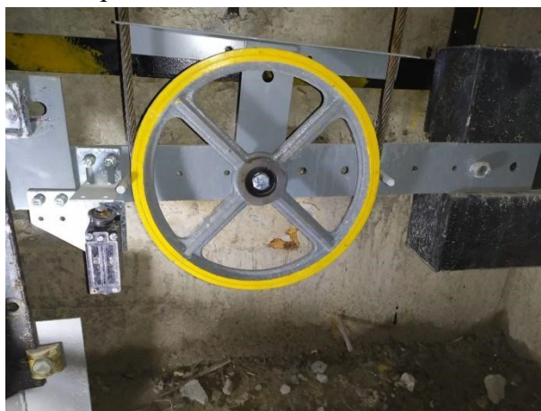
Рисунок 5.21 - Сборка натяжного устройства ограничителя скорости
